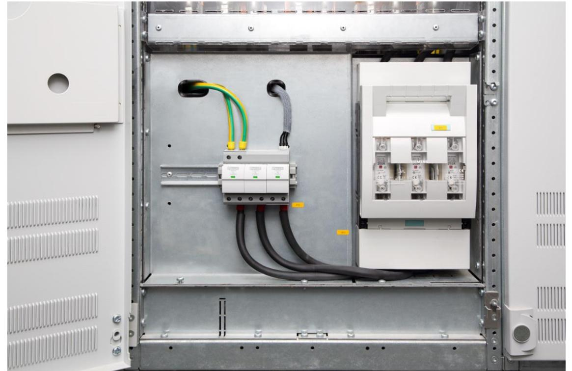
Überspannungsschutz für die Stromversorgung
